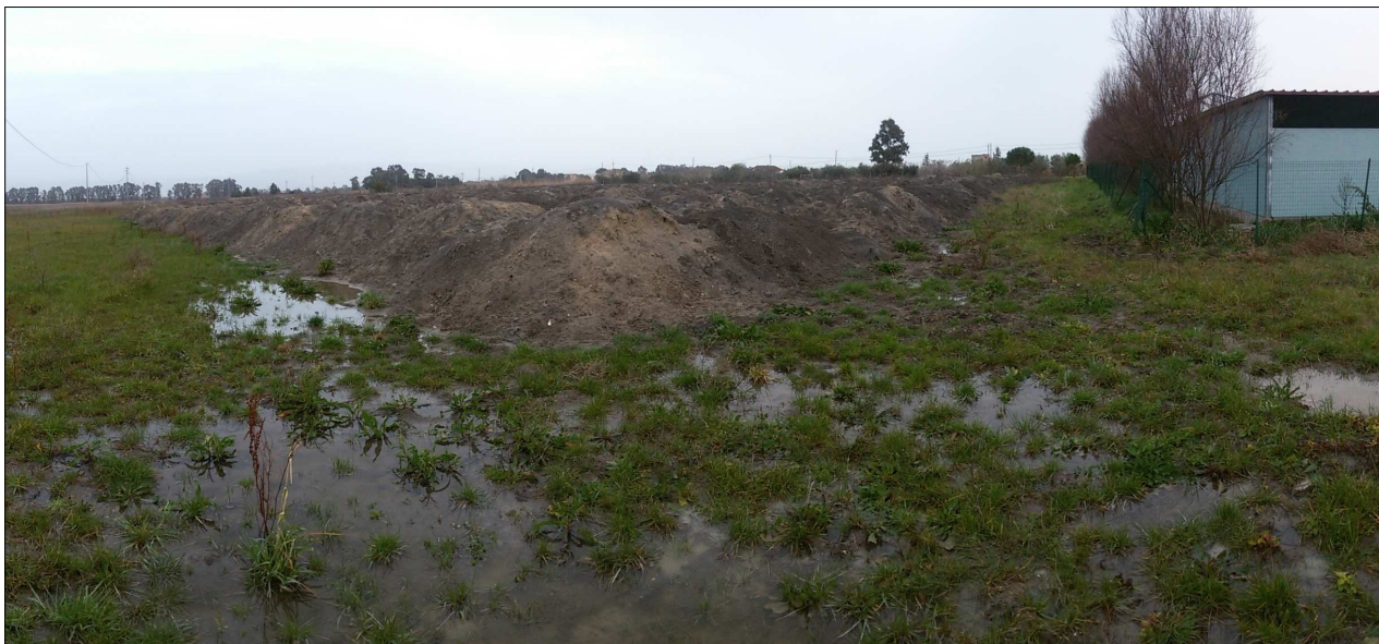
Foto 1 – vista dell'area da sud-ovest
